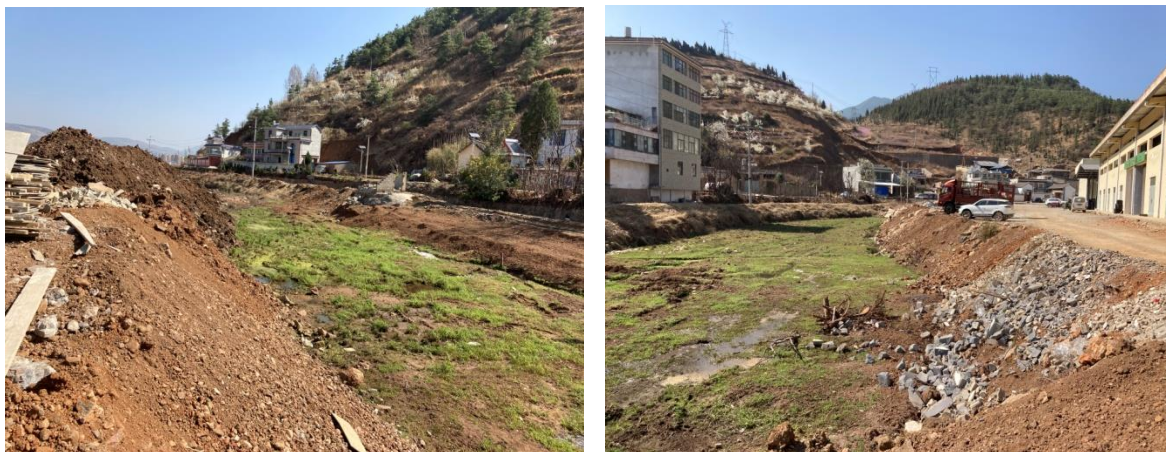
项目区后续建设需回填区域
