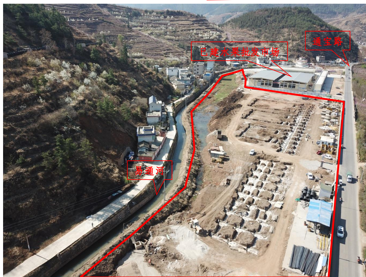
项目区建设现状
